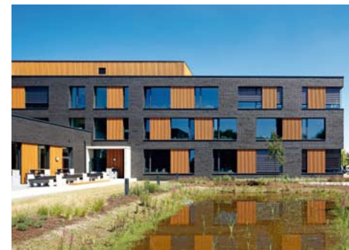
Doskonałe połączenie: budynek administracyjny firmy Hermes
