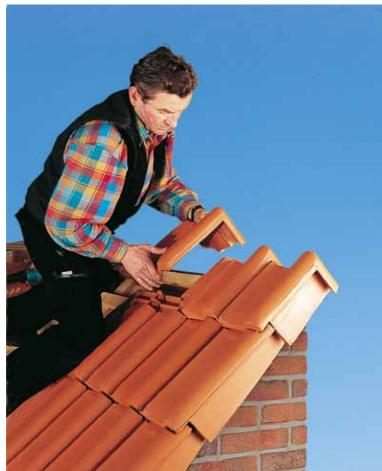
Montaż dachówki pulpitowej
